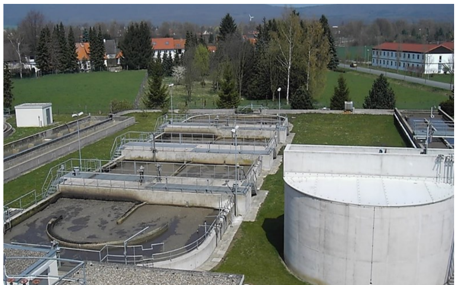
Ansicht der Kläranlage Springe / Foto: Stadtentwässerung Springe
