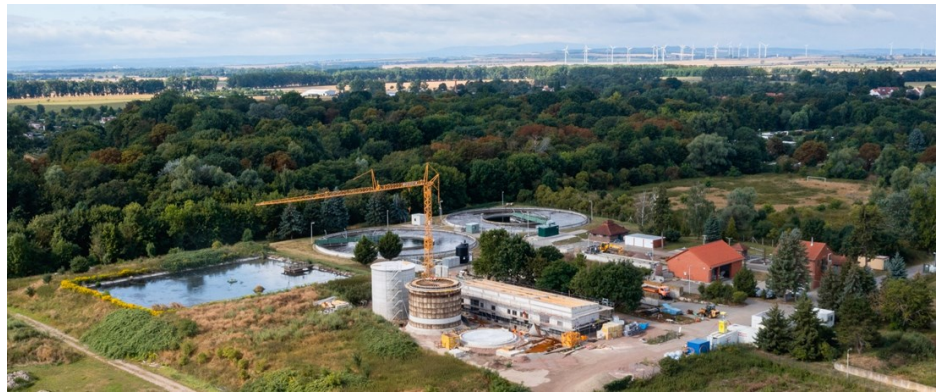
Luftbild der Kläranlage Oschersleben – Sicht auf Klärschlammfäulungskomplex August 2021 (Foto: © TAV Börde)
