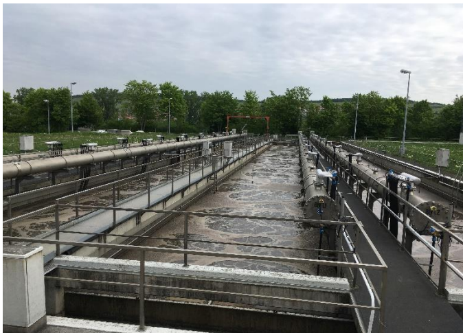
Kläranlage in Winterhausen
